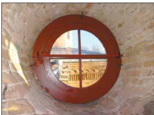
Tahkuranna kiriku kellatorni ümaraken.
